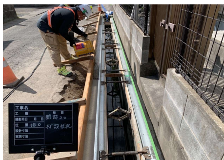
施工中 ～ 間詰コン打設状況 ～
