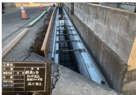
施工中 ～ 側溝上部改修製品据付完了 ～
