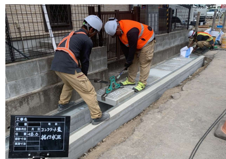
施工中 ～ コンクリート蓋据付状況 ～
