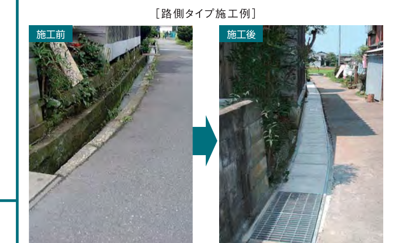
[消音タイプ(施工後)]
